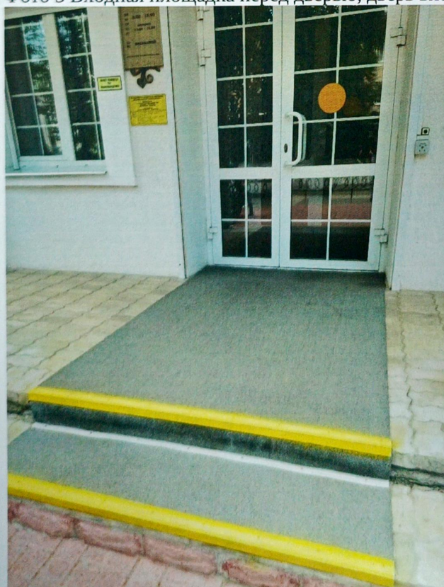
Фото 3 Входная площадка перед дверью, дверь входная
